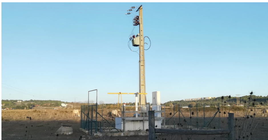
Figura 2.3.4.15: Posto de transformação aéreo. Fonte: EP.
