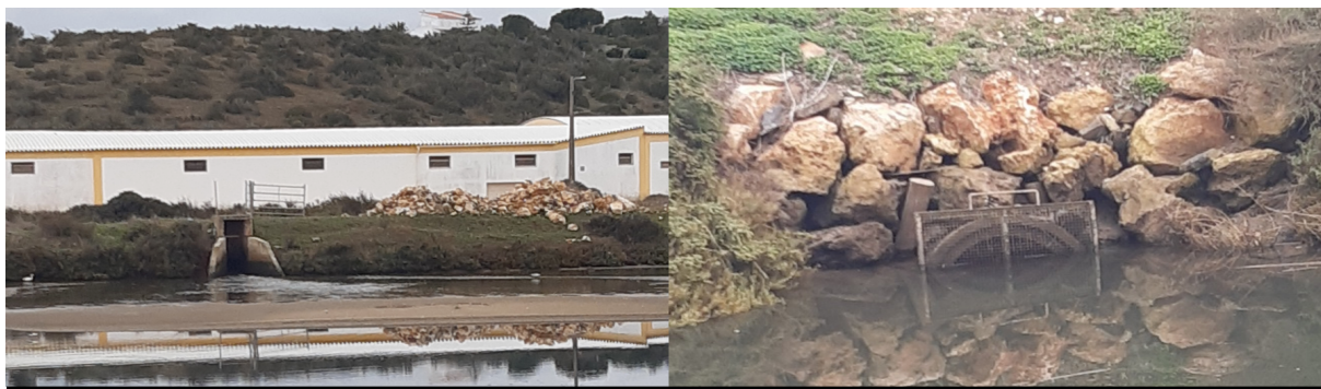
Figura 2.2.3.6: Estruturas hidráulicas que permitem a circulação de água e a alimentação das lagoas. Fonte: EP.
